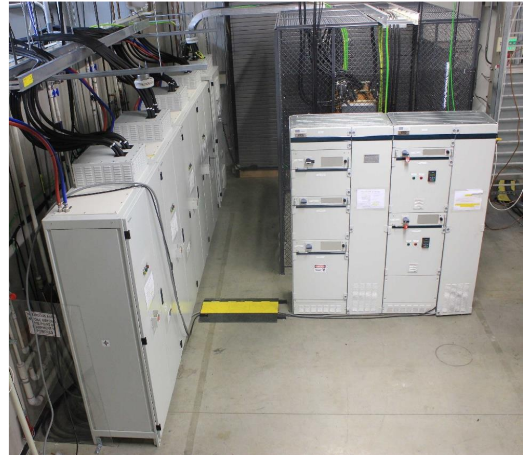
Rectifiers, MCC, transformer
